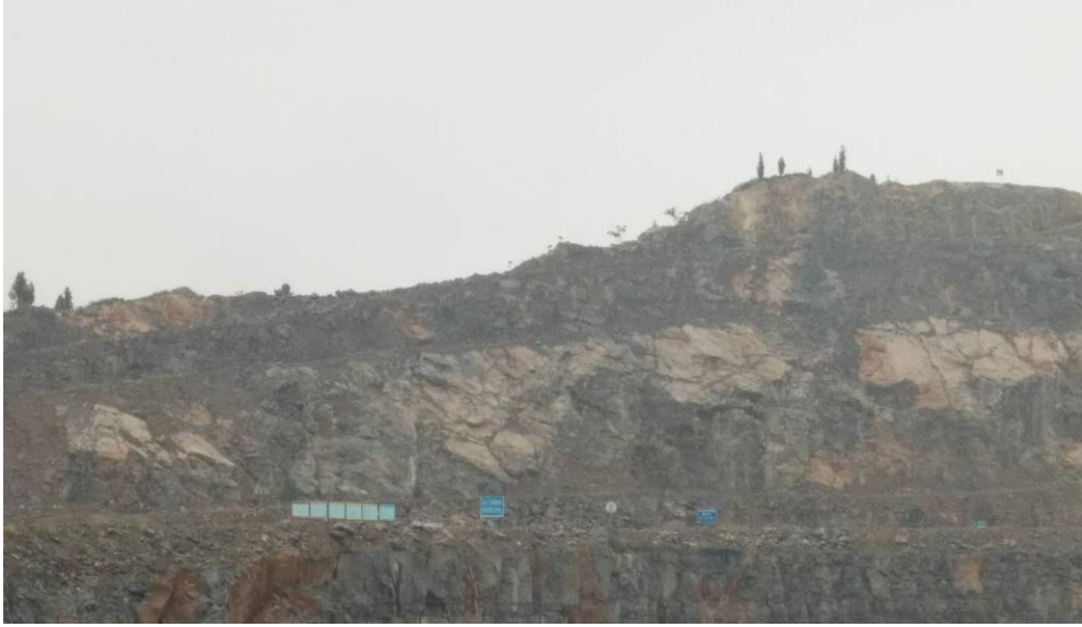
照片 2-6 矿山 A 区台段边坡治理前现状
