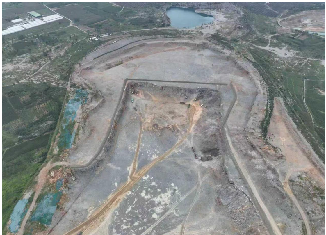
图 2-4 矿山南侧采场航拍照片
