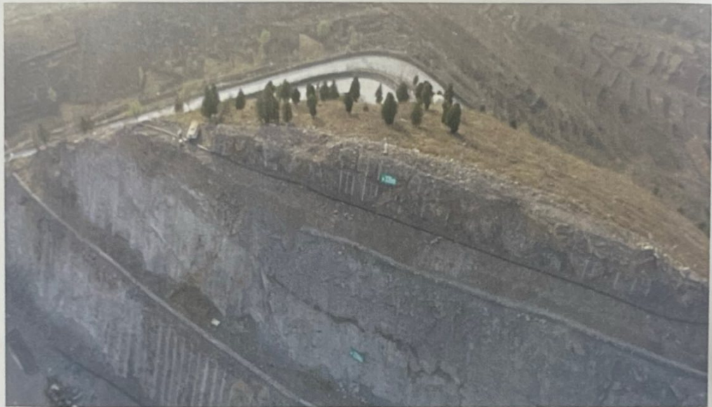
照片 2-7 依山口矿区西侧现状终了边坡（东北向西南拍摄）
