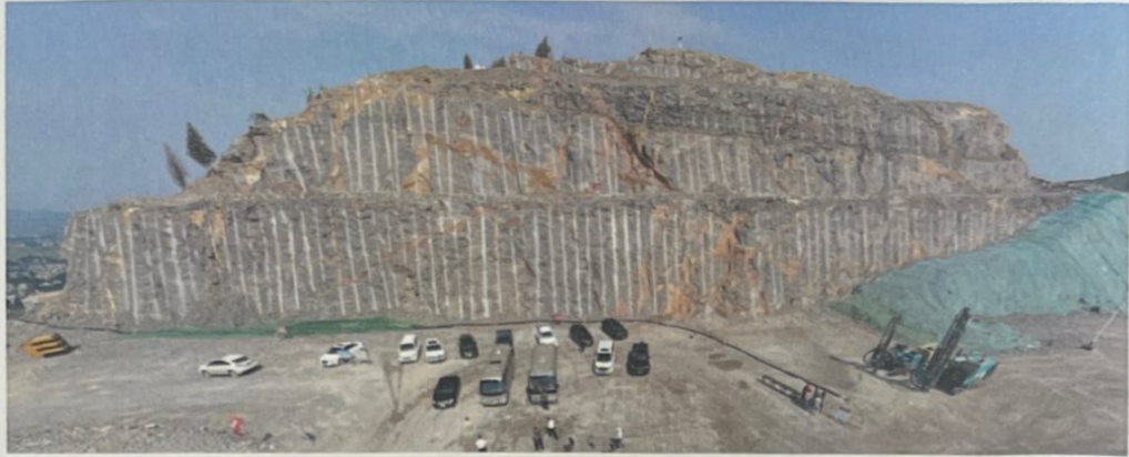
照片 2-6 依山口矿区西侧现状终了边坡（东南向西北拍摄）
