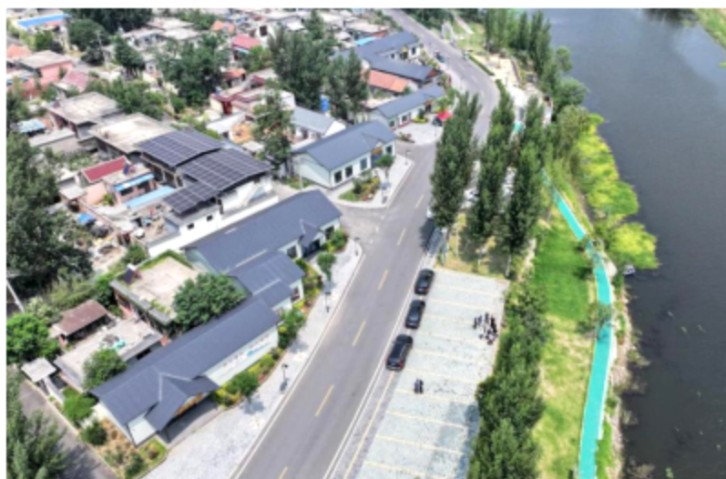
图 4.3.2-2 “三湾里·薛河古韵”片区
