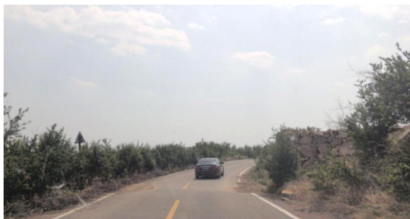
图 1.2.1-5 西门-车峪水库段现状
